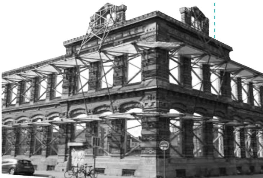
Cosmopole, source : https://nordfranceconstructions.fayat.com/fr/actualites/le-cosmopole-un-nouveau-chantier-au-coeur-de-lille
